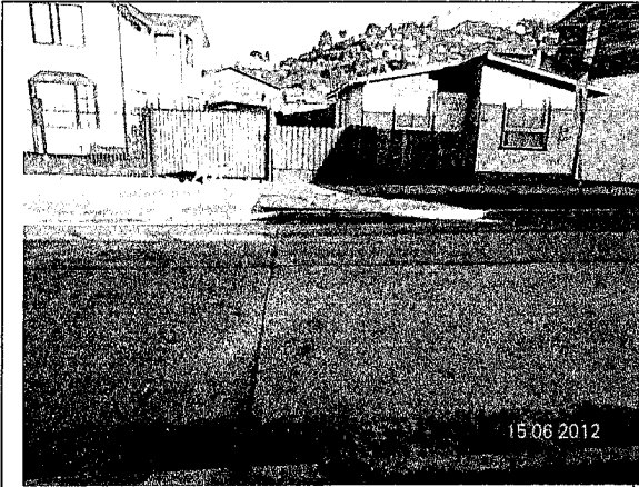
FOTO N° 6 PAVIMENTO DESGASTADO
